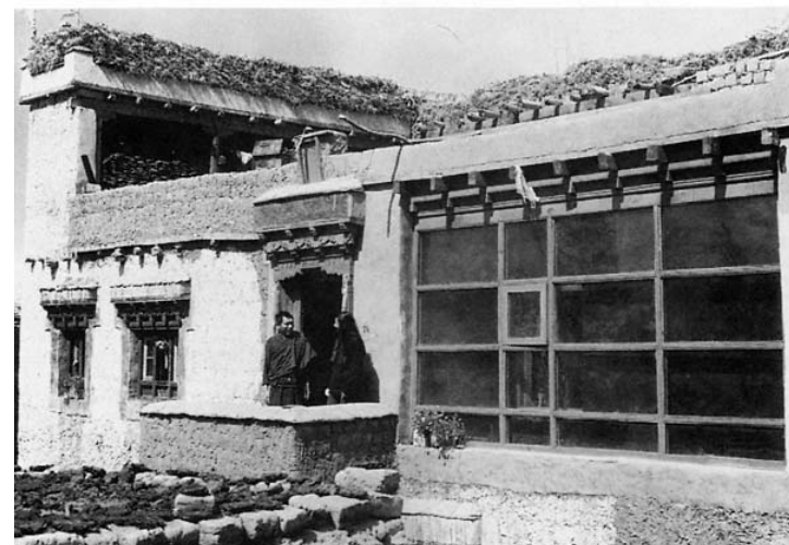
A Trombe-fal napenergiás fűtőrendszere egy magánházon Saboo faluban. A helyi mesteremberek által épített fal jól illeszkedik a hagyományos építészethez.
